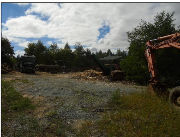
Abb. 6: Blick auf das östliche Zentrum des Plangebiets aus Nordwesten.
