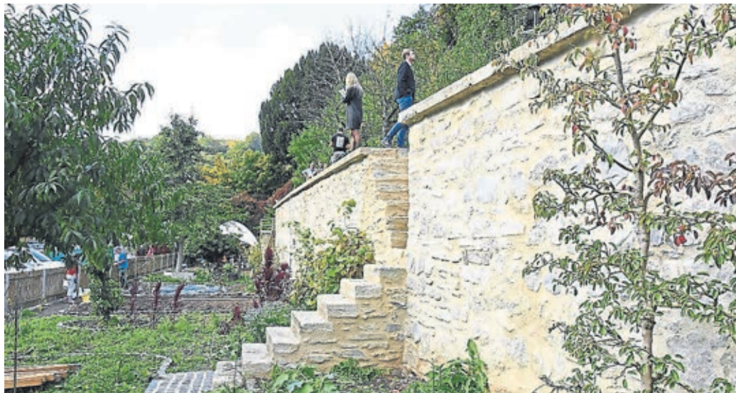
Die neue Treppe und die sanierte Mauer sind nun die Schmuckstücke der Terrassengärten.
