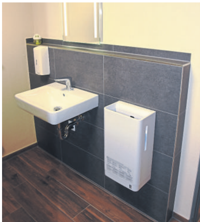
Blick in den Sanitärbereich.
